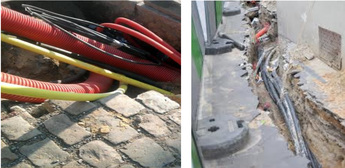
Figure 1 | Tranchées nécessitant un remblayage
