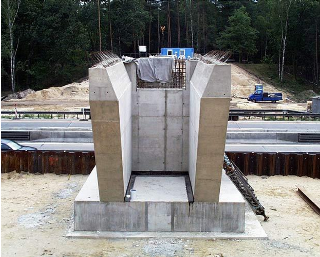
Figure 6 | Culée de pont
