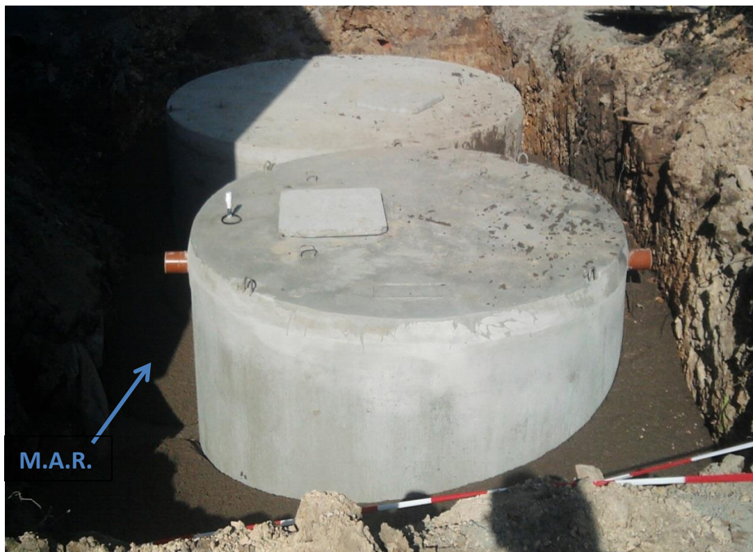
Figure 5 | Remblayage de la fouille autour d'une citerne à l'aide de MAR
